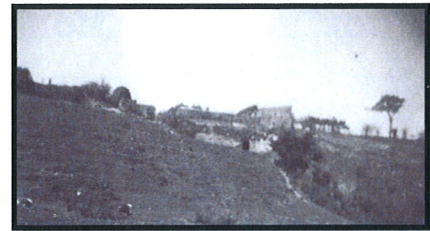
Entrée souterrain du Coteau 1940
