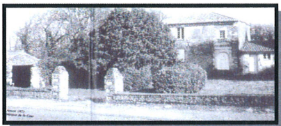
Maison de la Cour 1972
