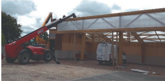
En cours : l'extension des ateliers municipaux
