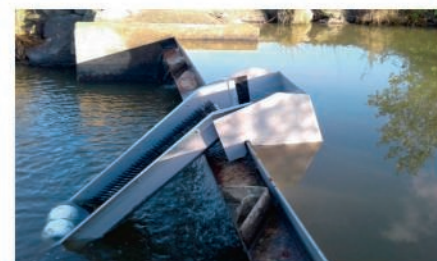
Le clapet de la Gatelière après travaux
