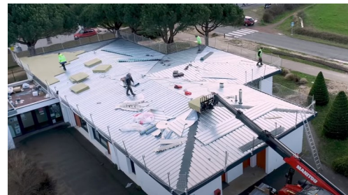
Reprise de la toiture de l'accueil de loisirs et du restaurant scolaire
